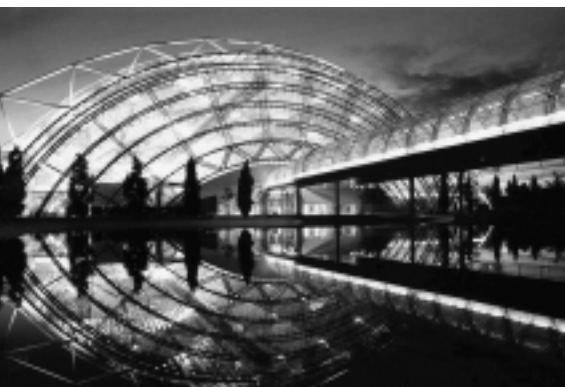
Verbindungsrohre zwischen Glas- und Messehalle, Foto: Leipziger Messe GmbH
